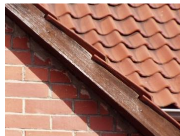
Hohlpfannendeckung mit Zahnleiste am Ortgang
