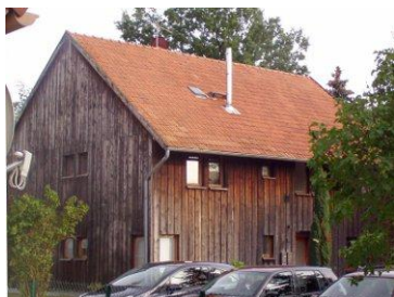
Mit Holzverkleidungen lassen sich Umbauten landwirtschaftlicher Gebäude dorfgerecht in das Ortsbild integrieren
